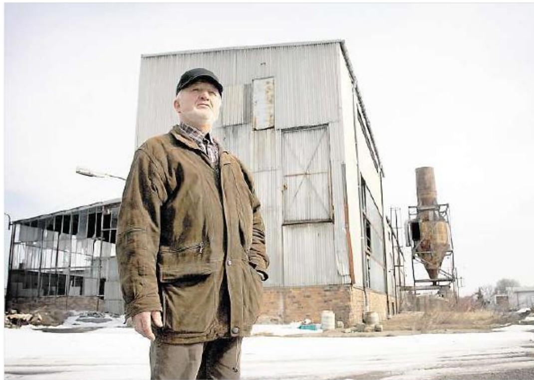
Lothar Brückner war Chef des Trockenwerkes Platro in Großröhrsdorf. Hier wurde bis 2003 Tierfutter hergestellt. Dieses Jahr rollt der Abrissbagger an.
