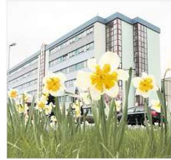
Das Schweitzerhaus wurde in den 90er-Jahren umgebaut. Jetzt muss auch hier saniert werden.
