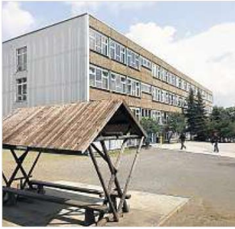
Die 2. Mittelschule in der Saarstraße ist sanierungsfällig. Das würde vier Mio Euro kosten.
